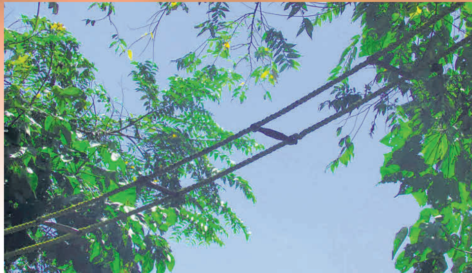
Puente mono sobre quebrada Macho, Limones.
